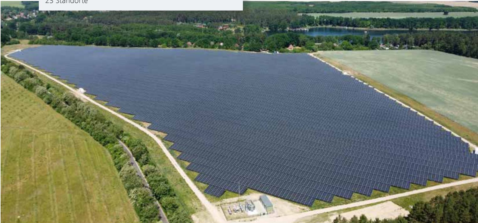
Solarpark Strasen, Mecklenburg-Vorpommern
